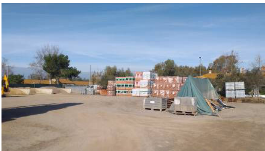
Situazione esistente all'interno del piazzale
